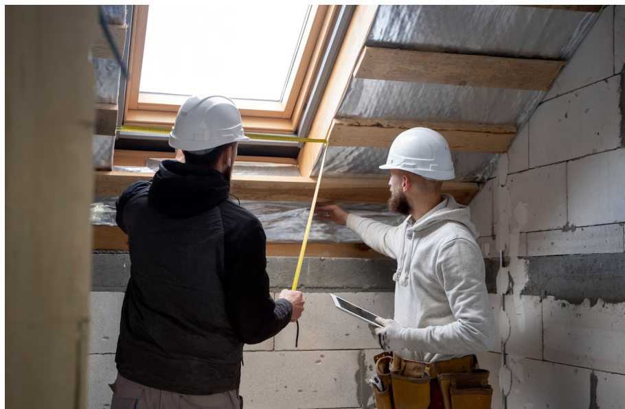
Zdjęcie 3: Ocieplenie dachu budynku
