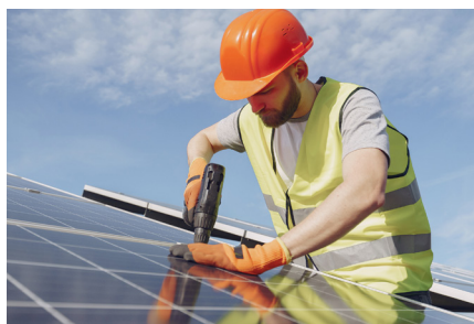
Zdjęcie 4: Montaż instalacji fotowoltaicznej
